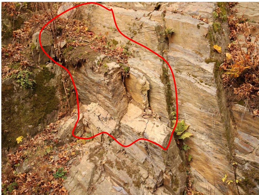
OBR. 3: PŘÍKLAD LABILNÍHO MNOŽSTVÍ ROZVOLNĚNÉHO MATERIÁLU VE SKALNÍ STĚNĚ, VYZNAČENÁ OBLAST MÁ OBJEM CCA 0,36 m 3 , SMILOV U HRUBÉ VODY, JÍLOVITÉ BŘIDLICE AŽ PRACHOVCE
